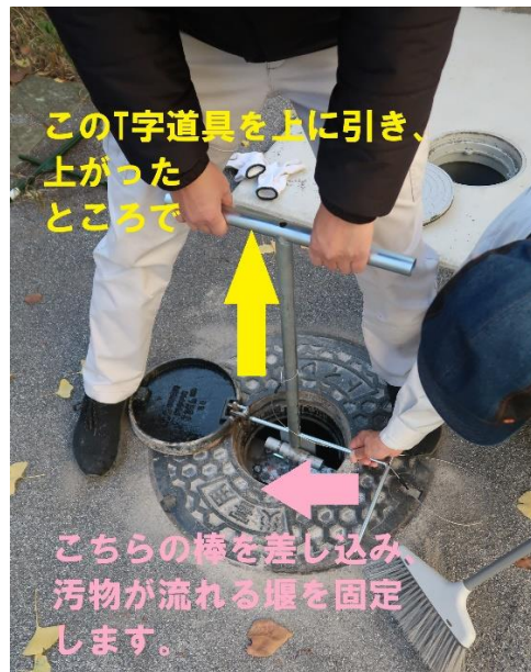
⑯堰は重さで自動で閉じます。排泄物が流れている間、堰を開けておく必要があります。
