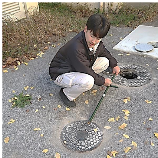
⑪てこの原理を使って、マンホールを押し 上げます。
