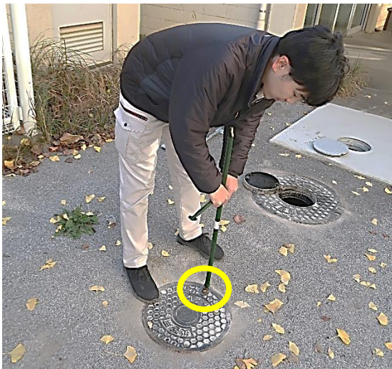
⑩レバーを使ってマンホールを外します。 ○の個所に強めにレバーを押し込みます。
