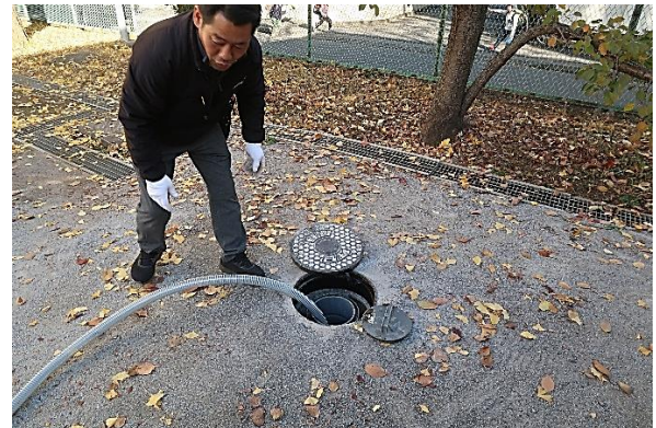
⑥水を入れるためのマンホールに排水されるホースを入れます。
