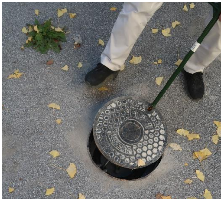
⑫マンホールが空いたらそのまま 引っ張り、90度回転させます
