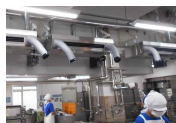
給食室の空調設備新設
