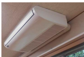
教室のエアコン交換
