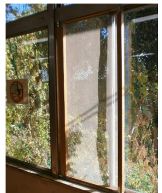
手作りの木枠にタッカーでネットを固定します。
